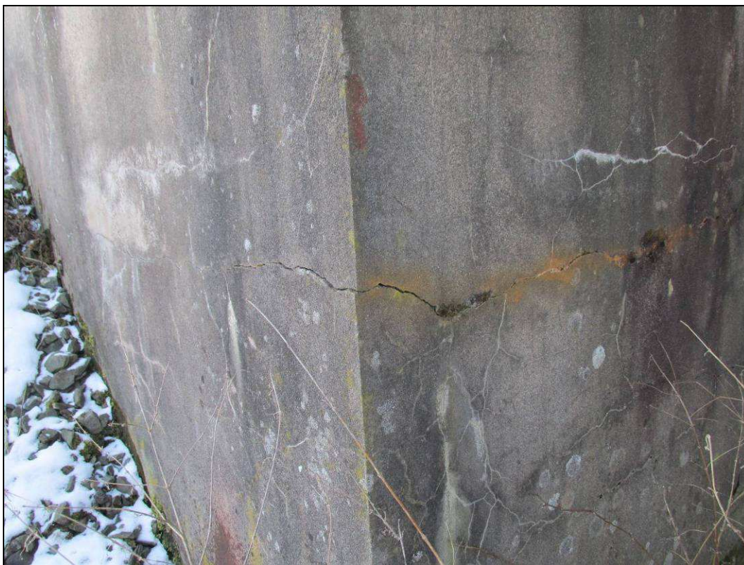
Obr. č. 8 - podélná trhlina šířky 3mm - pravé nároží opěry Libina
